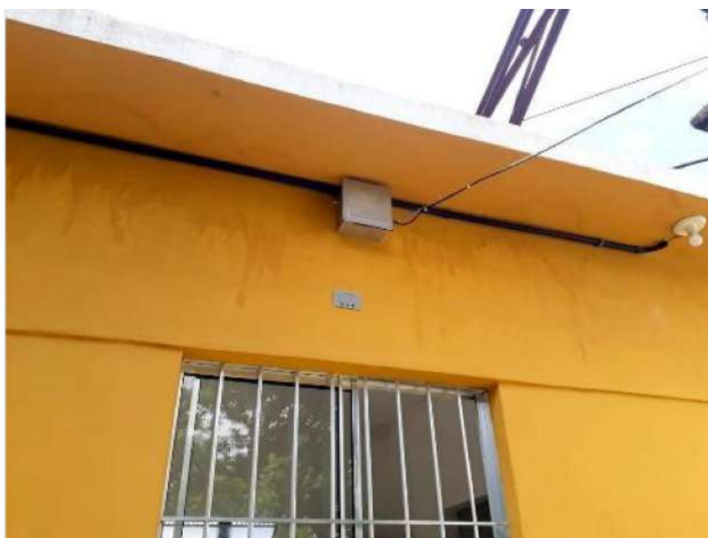
Guarita pronta para instalação do Intragov, 2020.
