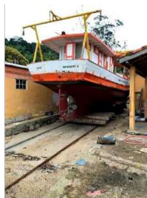
Puxada na carreira do Bp Albacora na Base de Cananéia para reparos, em 09/08/2018.
