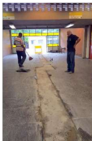
Substituição de canos de ferro por PVC, correção de vazamentos no Salão Azul e acidentes na laje.
