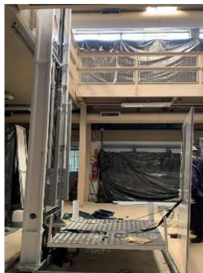
Instalação da plataforma de acessibilidade ao mezanino e ao andar superior.
